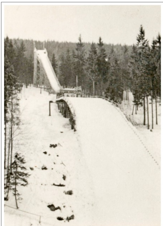
Opravený můstek v roce 1954
