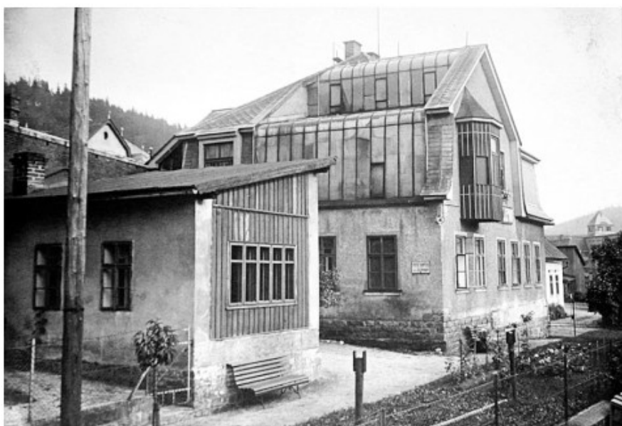
Podoba domu s fotoateliérem v patře krátce po přestavbě
