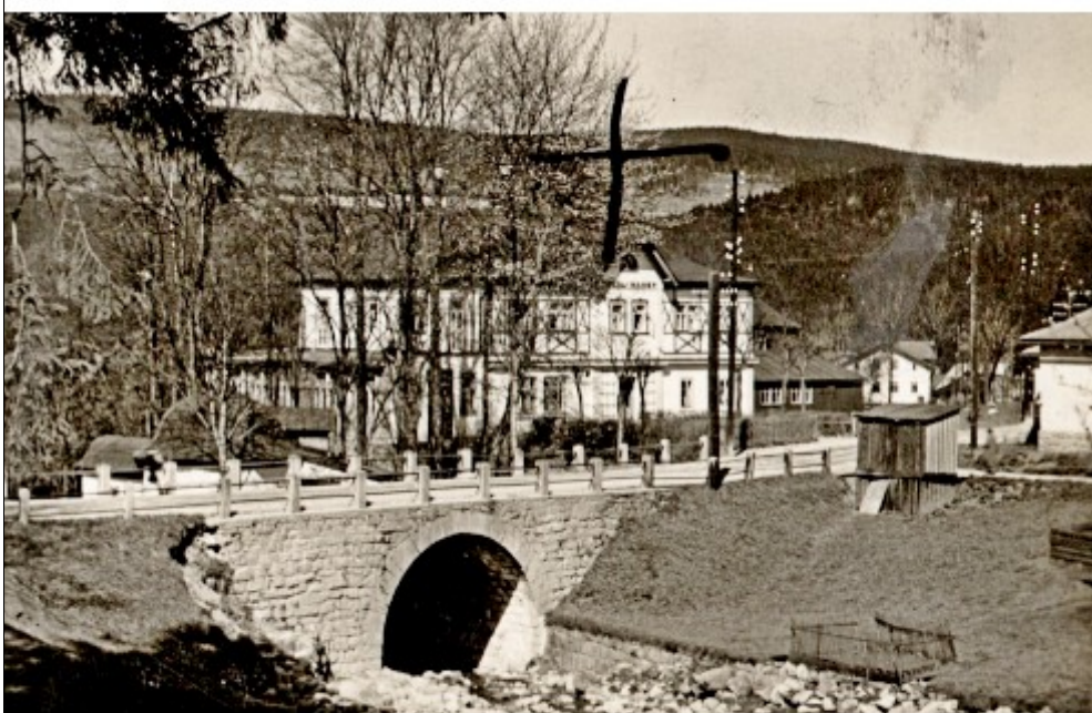
Pohled na hotel Haney s ubytovnou přes řeku Kamenici
