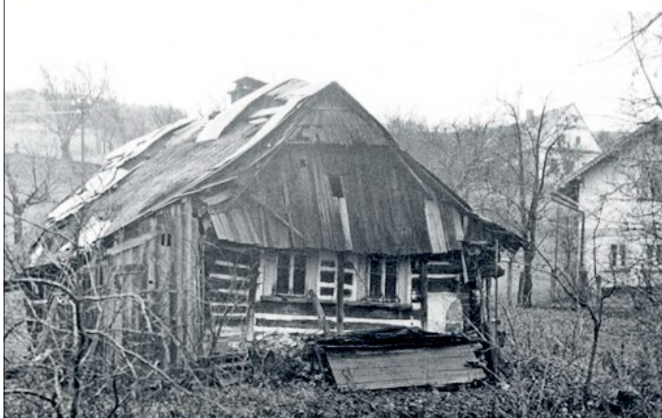
A že všeho je do času, to nám připomene třeba dnes již zbořená malá chaloupka stojící původně v místech dnešní hořeni požární nádržky.
