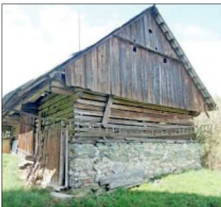
Dnes již zbouraná stodola z Přívlastkého kopce, jejíž trámovi bylo alespoň částečně druhotně použito jako „náhradní díly“ pro rekonstrukci Reinišova statku.
