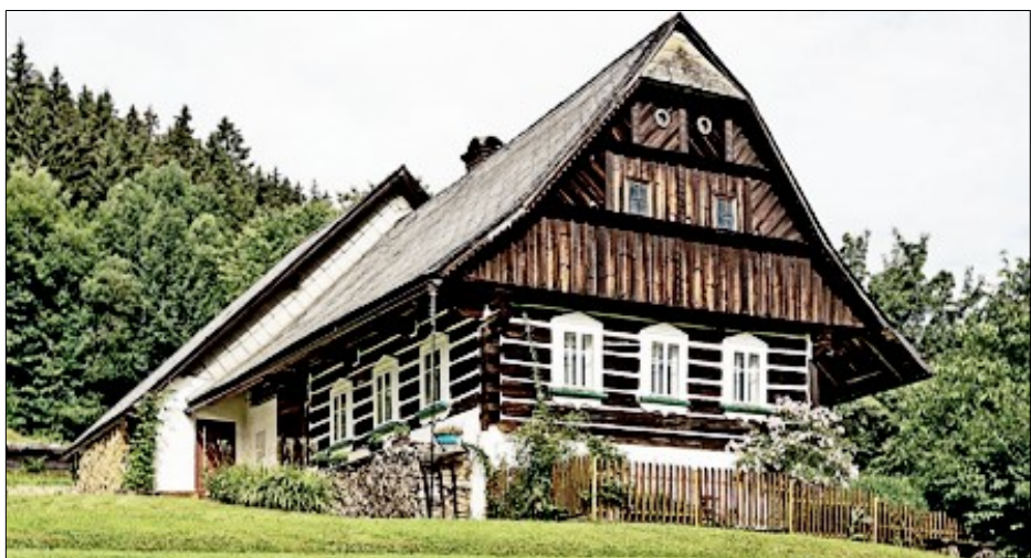
Jedna z nejhezčích Přívlackých chalup, č.p. 424 nese pod kabřincem rozkošné záklopové prkno (na dalším snímku).
