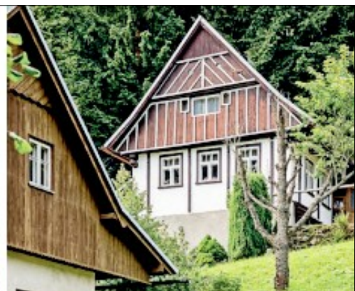
Roubení chalupy čp. 429 na Přívlastce je skryto „pod kožichem“. Znamky roubení však pozorné oko odhalí ve vystupujících zhlavích vrchních trámů, jakož i ve svislých kleštinách.
