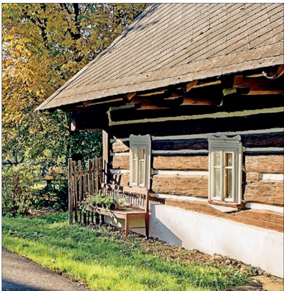
Skvostná chalupa U Jírů (čp. 219), která hostila i školu i hospodu (dobrá kombinace) a která je roubena z nestejně silných a nadto již notně sesedlých trámů – pohlazení pro oko! Na snímku si povšimneme i pěkných šambrán kolem oken.
