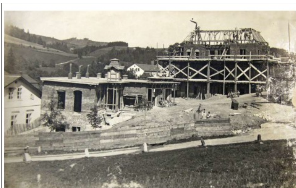
Snímek z roku 1891, ze stavby domu č.p. 336
