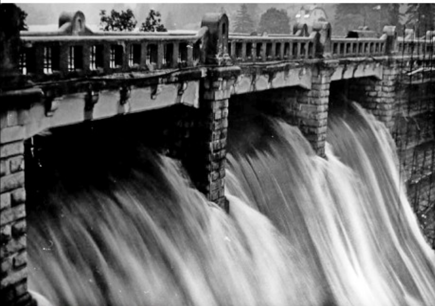
Historické snímky Labská přehrada Špindlerův Mlýn.
