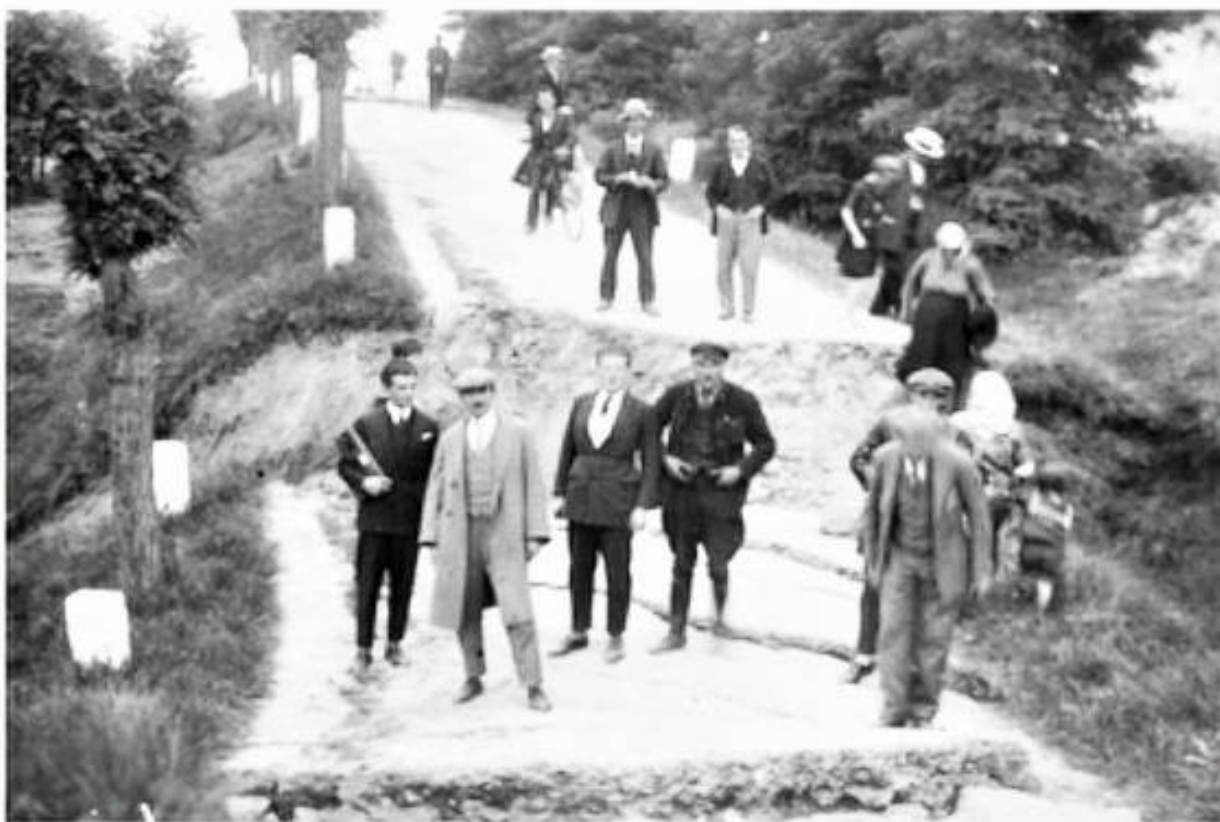
Poškozená silnice ze Dneboha na Olšinu
