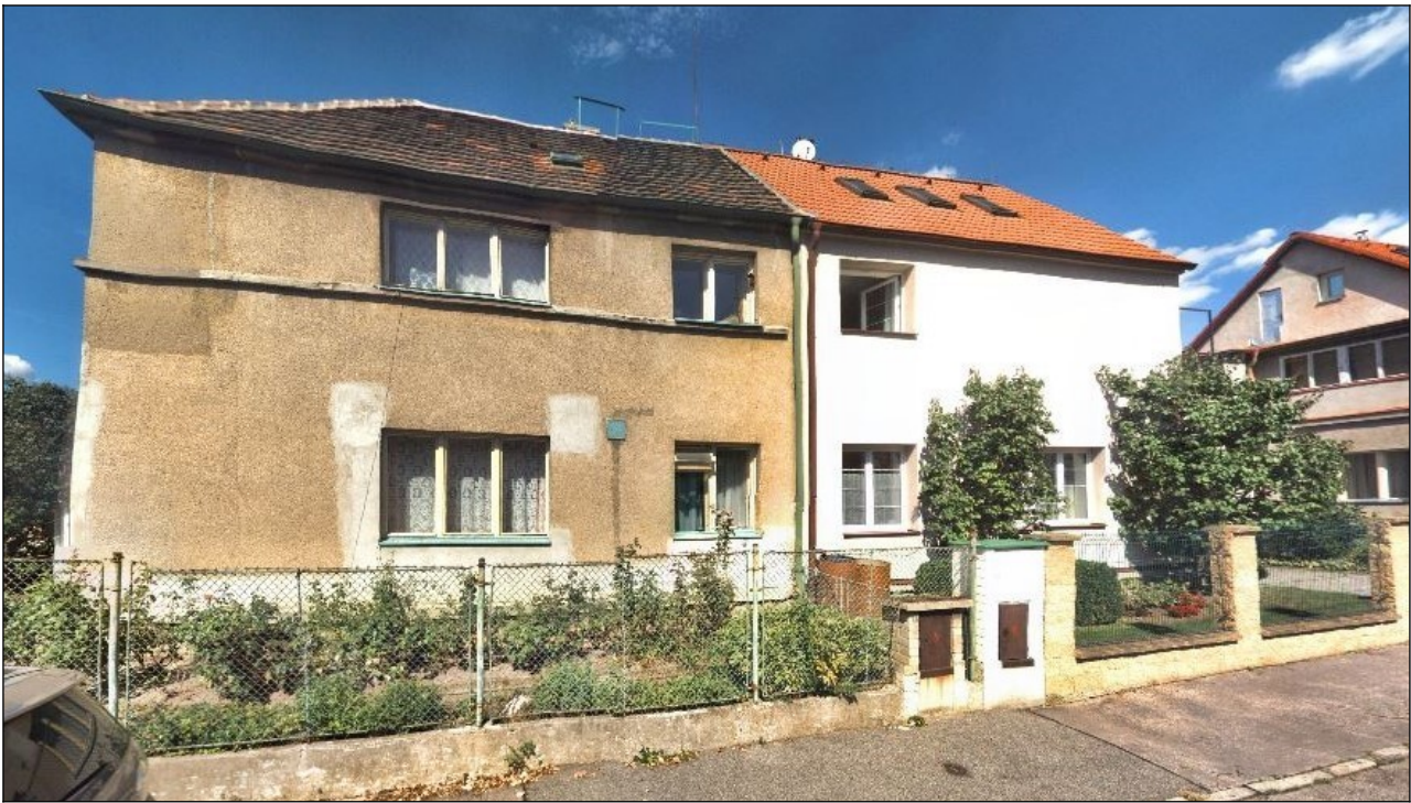
Havlíčkovice dvojdomek na Spořilově
